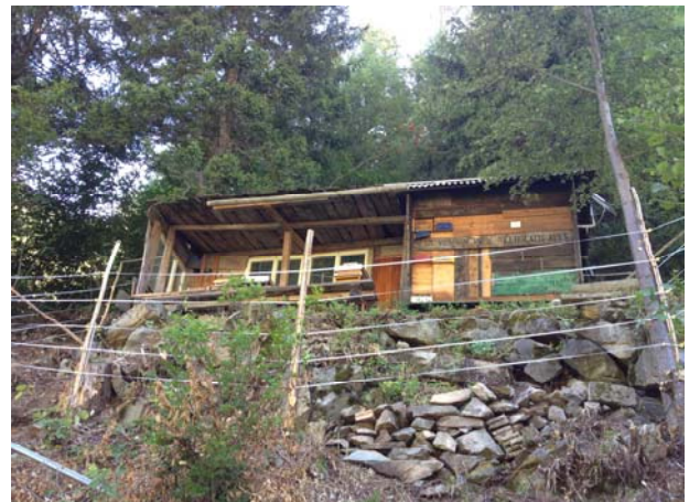
Zum Teil musste in sehr schwierigem Gelände gezäunt werden.
